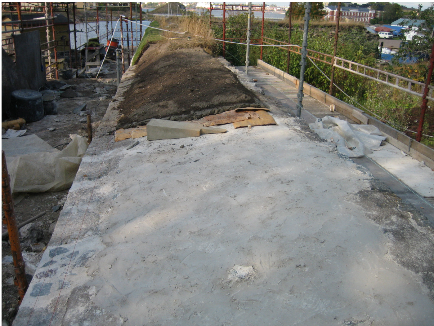
Bastioni Hamiltonin rintamuurin päällä ei kävellä. Täten savi ja tuohieristystä suojaava maakerros ei kulu. Kuva: Suomenlinna B21, bastioni Hamilton. 14.9.2005 / Kaj Holmberg
