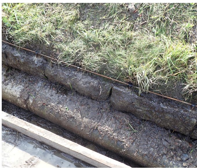
Bastioni Wreden turvetustyön vaiheita: ohjuri, alustan työstäminen, kasteltujen ja 10 cm paksujen turvetiilten latominen lappeelleen sekä valmis pinta. Turvetiilien pysyminen muurinharjalla on varmistet- tu ohuella harjateräksellä. Kuvat: Suomenlinna B49, bastioni Wrede. 23.7.2020, 29.7.2020, 30.7.2020 / Tuija Lind
