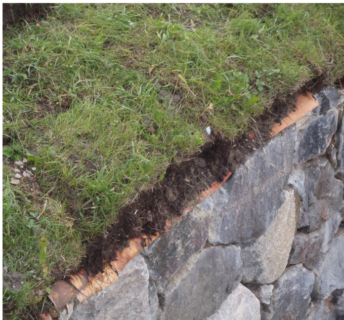
Jos tuohieristys jää näkyviin, se käpristyy kuivuessaan, jonka jälkeen tuuli vie sekä eristykset että multapaakut mennessään. Kuva: Suomenlinna B50, tenalji Casimir Wrede. 1.10.2012 / Tuija Lind
