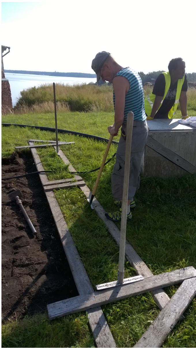
Turvetiilten nostoa muotin ja petkeleen avulla Kustaanmiekan am- pumatasanteelta. Kuva: Suomenlinna A7b, bastioni Lantingshausen. 12.8.2015 / Ulla Räihä
