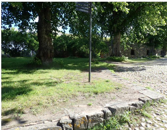
Päävartion vesieristetty sokkeli, sekä puuttuvan rakennuksen päälle sijoitettu opastepylväs. Kuva: 11.8.2020 / Tuija Lind
