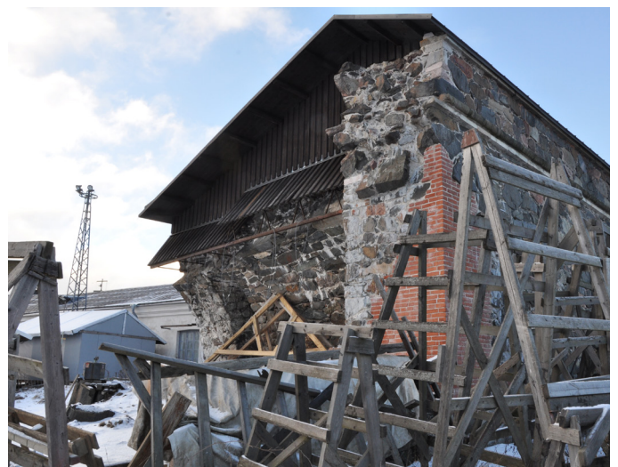
Suomenlinnan telakalla sijaitsevaa 1700-luvun bastioni Taubea purettiin ensin 1930-luvulla ja sen jälkeen vuonna 1948. Vuonna 2007 bastionin puretun osan jäljet konservoitiin taitavalla muurinkorjauksella ja raunio-osien suojaksi suunniteltiin puinen katos (suun. arkkitehti Tiina Koskenniemi). Kuva: Suomenlinna B12, bastioni Taube. 7.2.2017 / Santina Ambrosini
