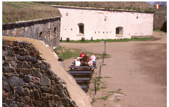
Tenalji Kyhlenbeckin ja kaponieri Hoppen väliseen kurtiinimuuuriin avattiin leveä kulkuaukko 1880-luvulla. Hoppen puoleinen muuri jätettiin osittain raunioasuun. Muurin yläreunaa korjattiin sementtilaastilla ilmeisesti 1950-luvun alussa. Sementtilaastin avulla olisi ollut helppo tehdä myös esteettisempi, rikkonainen muurinharja. Kuva: Suomenlinna A10, kaponieeri Hoppe. 1999 / Pekka Hänninen
