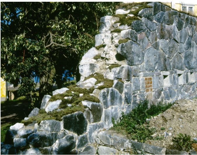
Bastioni Schefferin kärki purettiin 1900-luvun alussa rakennuksen D26 tieltä. Linnoitusmuurin restaurointityössä 1990-luvulla sen raunioitunut osa pyrittiin korjaamaan niin, että se näyttäisi itsestään syntyneeltä, ajan rauniolta. Rikkonaisen pinnan muuraus korjattiin sekä kivet aseteltiin hydraulisen kalkkilaastin avulla niin, ettei niiden väliin jäänyt vettä kerääviä kuoppia. Muurauksen avulla sadevesi ohjattiin pois muurin päältä. Laastipintojen suojaksi istutettiin sammalta. Tämänkaltaisen rakenne edellyttää ylläpitoa. Kuva: Suomenlinna D1, bastioni Schefferin oikea kylki. Syyskuussa 1995 / Tuija Lind
