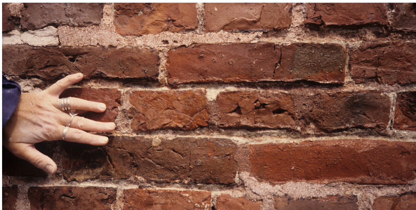
Laivaston leipomorakennuksena toimineen tenalji von Fersenin julkisivu on muurattu 1770-luvulla kirjavan värisistä ja eri kokoisista kivistä. Jälki- saumatukset ovat eri aikakausilta. Kuva: Suomenlinna B17c, Tenalji von Fersenin eteläjulkisivu, yksityiskohta. 2.7.1996 / Tuija Lind
