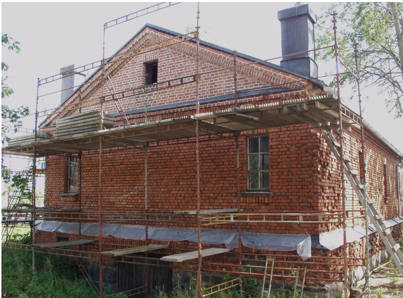
Miinapajan länsipäädyn harjan saumaustöitä Lonnassa. Kuva: Suomenlinna H2. 24.08.2004 / Reetta Amper
