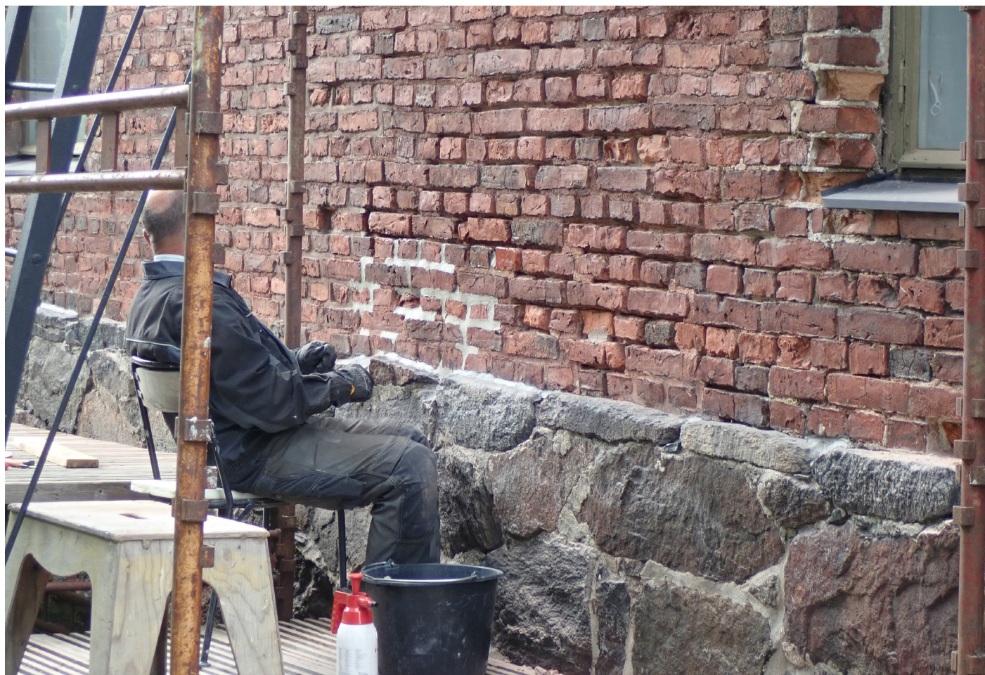
Tauno Satolaisen tiili- ja sokkelikorjauksia. Kkh-laastisauma patinoidaan veteen sekoitetulla pigmenttiseoksella ja se haalistuu jatkossa. Kuva: Suomenlinna C40, Kruunulinna Ehrensärd. 12.08.2020 / Tuija Lind
