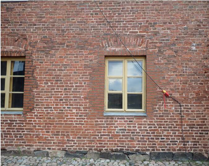
Fersenin vaaleat laastisaumat patinoitiin veteen sekoitetulla pigmenttil- lä. Pigmenttivelvi saa olla aika tummaa, sillä sade huuhtoo väriä vähi- tellen pois. Kuva: Suomenlinna B17c, tenalji von Fersenin leipomosiipi. 2.12.2020 / Tuija Lind
