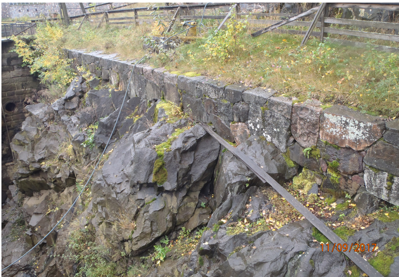
Kuvan muuri on esimerkki uudesta kylmämuurista, joka on rakennettu Suomenlinnan telakan ulkoaltaan reunan tukimuuriksi 2000-luvun vaihteessa. Muurin on rakentanut Tauno Satolainen (Kari Helenius Oy). Muurin tausta on täytetty kiviaineksella niin, ettei sen läpi kulkeudu maa-ainesta itse muurirakenteeseen. Muuri läpäisee kaiken kalliota pitkin valuvan ja maan läpi suodattuvan veden; vesi ei patoudu muurin taakse, eikä muuriin täten kohdistu maan tai jäätyvän veden aiheuttamaa painetta. Kuva: Suomenlinna, Susisaari, telakan ulkoallas. 11.9.2017 / Tuija Lind
