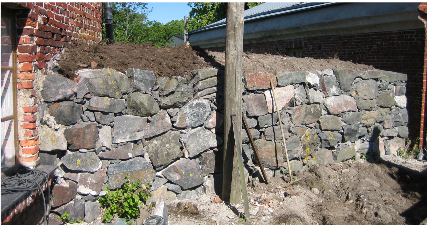
Susisaarella, bastioni Palmstiernan tallin B41 ja nk. Ateljeetalon B44 välillä sijaitseva puolustusmuuri oli putoilevine muurikivineen muuttunut vaaralliseksi 2000-luvun alussa. Korjaustyön yhteydessä kasvillisuus ja routiva maa-aines poistettiin, pudonneet kivet nostettiin takaisin ja kivien välit kiilattiin ilman laastia. Kuvat: Suomenlinna B41, Pihamuuri ennen ja jälkeen korjauksen. 13.6.2007 / Kaj Holmberg, 17.7.2007 / Tuija Lind
