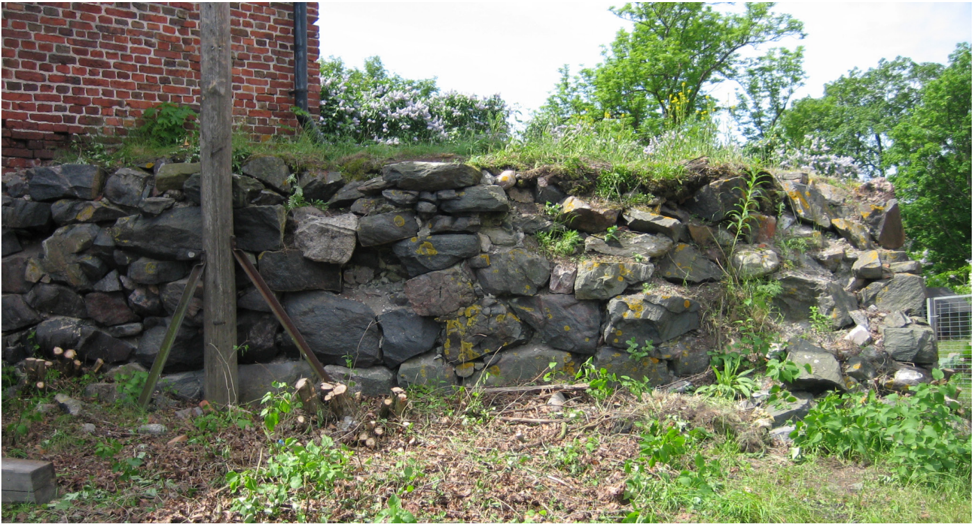
Susisaarella, bastioni Palmstiernan tallin B41 ja nk. Ateljeetalon B44 välillä sijaitseva puolustusmuuri oli putoilevine muurikivineen muuttunut vaaralliseksi 2000-luvun alussa. Korjaustyön yhteydessä kasvillisuus ja routiva maa-aines poistettiin, pudonneet kivet nostettiin takaisin ja kivien välit kiilattiin ilman laastia. Kuvat: Suomenlinna B41, Pihamuuri ennen ja jälkeen korjauksen. 13.6.2007 / Kaj Holmberg, 17.7.2007 / Tuija Lind
