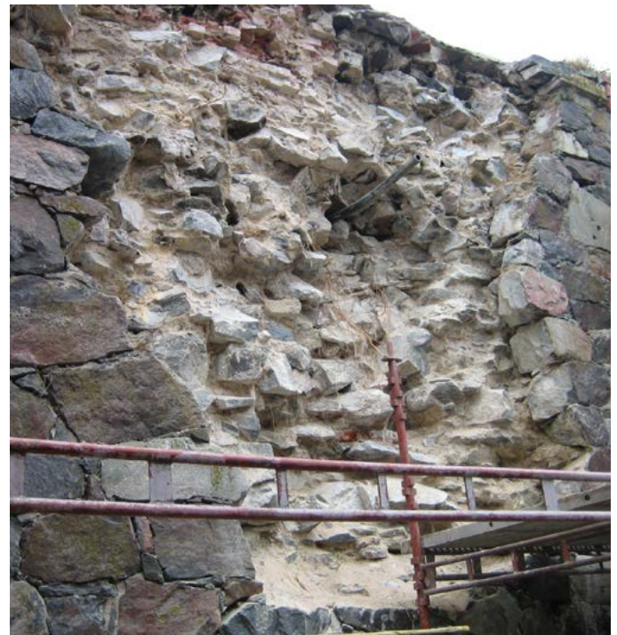
Bastioni Hyveen kasemattien välisen vedenheittäjän ympäriltä muuri oli pullistunut ja ainoa keino korjata se turvallisesti oli purkaa irtonaiset kivet V-muodossa lähes alas asti. Kuvat: Suomenlinna B48, Bastioni Hyve. 9.9.2007, 27.9.2007 / Kaj Holmberg
