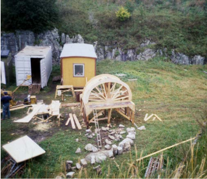
Suomenlinna A13. Kustaanmiekan rantavarustuksella kokonainen holvikaari jouduttiin sorruttamaan. Sen kivet numeroitiin ja palautettiin osittain samoilta paikoille. Kuva: A13 holvikaari 4:n kivet ja muotti. 1992 / Tuija Lind
