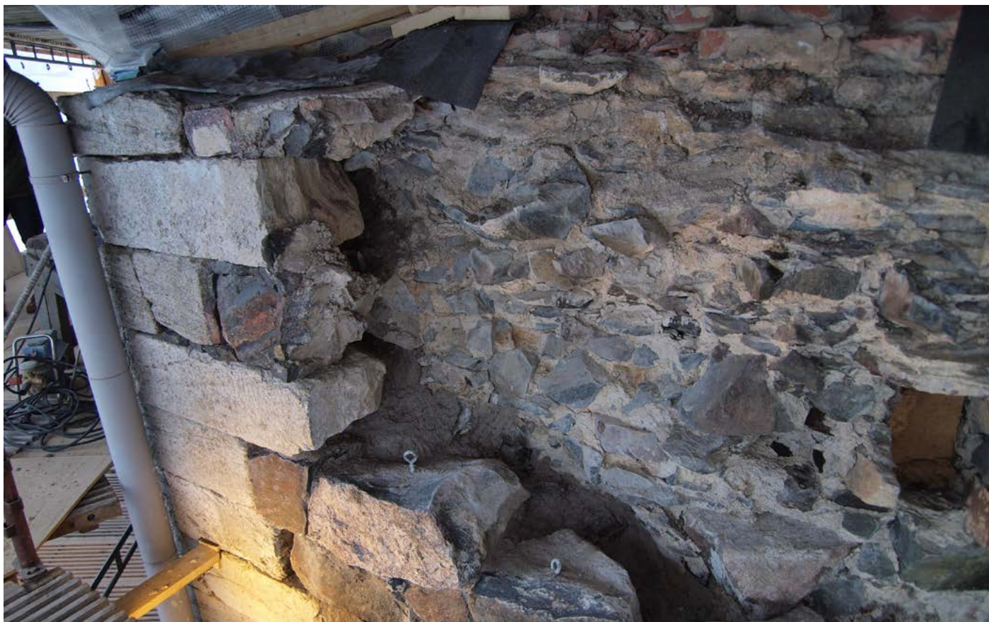
Bastioni Sethin vasemman kyljen purkaukon muurauksessa tukevasti asennettujen kivien tausta on esimerkillisen hyvin puhdistettu. Taustaa kostutetaan hyvin ennen täytekivien ja laastin käyttöä. Julkisivun taustan täytössä käytetään mahdollisimman suuria täytekiviä parantamaan muurin rakennetta. Varveittain tehtävä taustan laastitäyttö tulee jättää vajaaksi siten, että täytekivet jäävät osittain näkyviin. Näin seuraavan varvin täytekivet saadaan ladottua kivi kiveä vastaan, eikä laastin varaan. Kuva Suomenlinna B17d, Bastioni Seth. 13.2.2013 / Sakari Mentu
