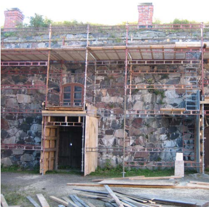
Bastioni Hyveen kasemattien välisen vedenheittäjän ympäriltä muuri oli pullistunut ja ainoa keino korjata se turvallisesti oli purkaa irtonaiset kivet V-muodossa lähes alas asti. Kuvat: Suomenlinna B48, Bastioni Hyve. 9.9.2007, 27.9.2007 / Kaj Holmberg
