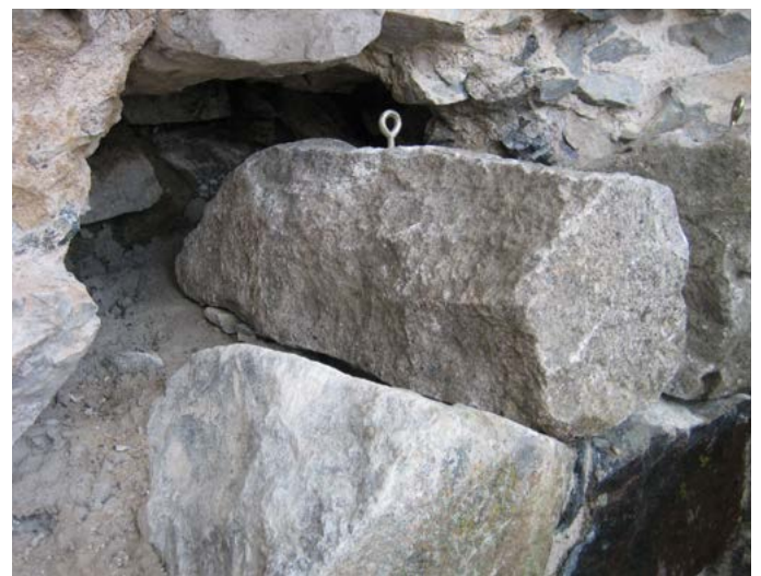
Valumuurin uudelleen muurauksessa on tärkeää, että julkisivukivissä on riittävästi pitkiä sidekiviä. Bastioni Hyveessä muurin ytimeen on varata vasten koverrettu aukko sidekivelle. Kuva: Suomenlinna B48, bastioni Hyve. Kaj Holmberg / 08.05.2008
