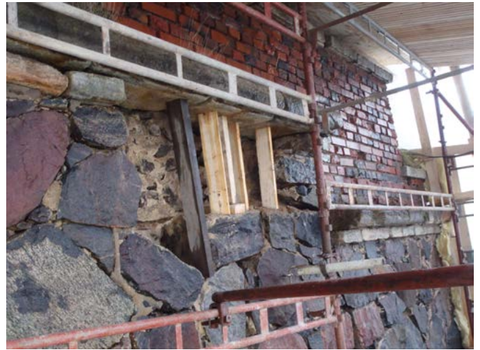
Bastioni Kunnian ampumatasolta valunut vesi oli kulkeutunut listakiven alapuolelle. Pullistuneet kivet irrotettiin ja kohta muurattiin uudestaan tilapäisiä tukia siirrellen. Kuva Suomenlinna B46, bastioni Kunnia. 21.12.2011 / Tuija Lind
