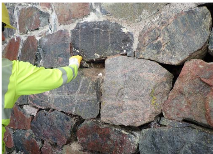
Kivien välistä poistetaan humus ja kaikki irtonainen kiviaines, mm. hiekaksi muuttunut kalkkilaasti.
