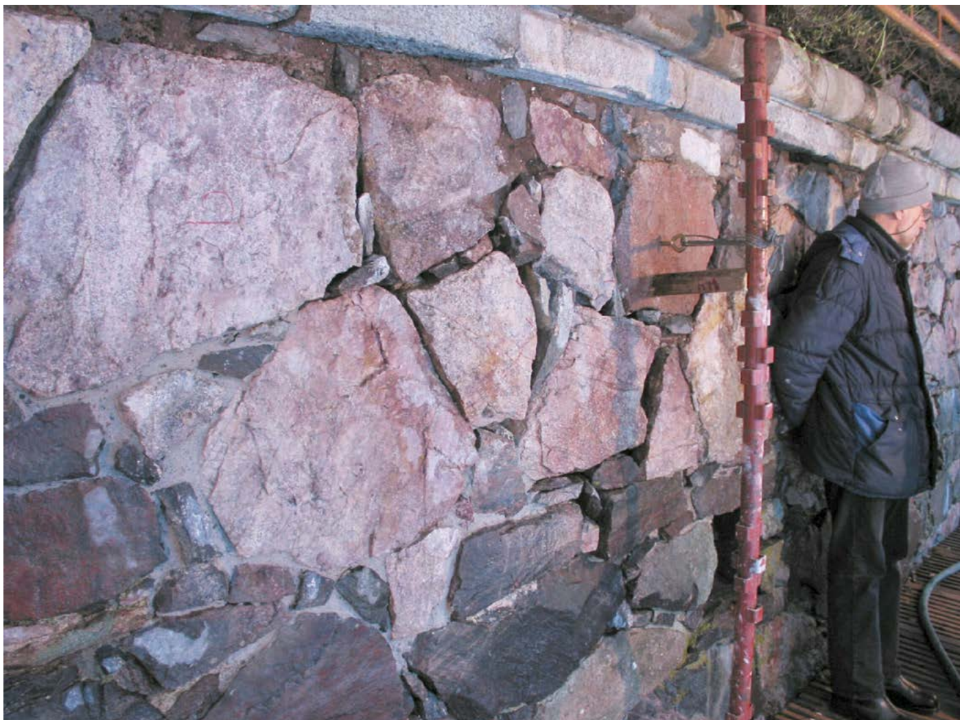
Vuodesta 1992 aina 2000-luvun alkuun muurinkorjauksessa käytetty hydraulinen kalkki oli kotoisin Juravuoristosta. Kun Jurakalkin valmistus lakasi, hoitokunta ja vankila etsi Thorborg von Konovin johdolla korvaavaa hydraulista kalkkia. Bastioni Wreden (B49) oikealla siivellä tehtiin useita pumppauskokeita ja päädyttiin St. Astier valmistajan NHL5 tuotteeseen. Kuva: Susisaari B49, Bastioni Wrede. Hoitokunnan valvoja Kaj Holmberg katsastamassa vuonna 2014 tehtyjä hydraulisen kalkkilaastin pumppauskokeita. 14.1.2004 / SLHK
