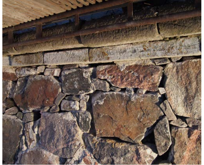
Puhdistetun muurin kiilakivet on asetettu paikoilleen odottamaan syvätäyttöä. Joitain kiilakiviä vielä puuttuu.
