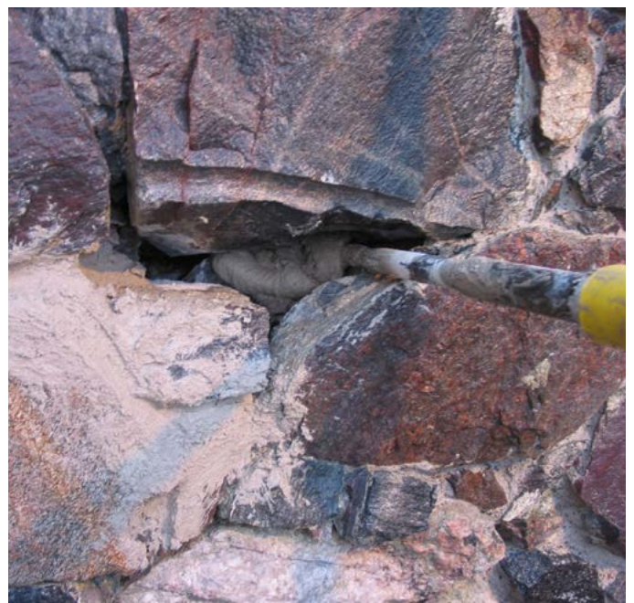
Laastin pumppaus meneillään. Pumpun suulake työnnetään aluksi mahdollisimman syvälle muuriin. Kuva: Suomenlinna B49, Bastioni Wrede. 20.03.2003 / Kaj Holmberg
