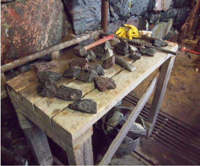
Kiilakivien työsto rakennustelineillä. Uusia kiilakiviä valittaessa täytyy ottaa huomioon kiven väri. Esim. liian vaaleat kiilakivet Suomenlinnan tummissa muureissa muuttavat muurin ulkonäköä.
