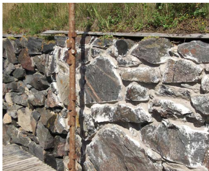
Muurin kuuraus tehtiin auringonpaisteessa ja ruokatunnin tauon ai- kana laasti jämähti kiinni kiviin. Puhdistustyö vei sen jälkeen useita päiviä. Kuva: Suomenlinna C56, taitettu kurtinimuuri. 20.7.2016 / Tuija Lind
