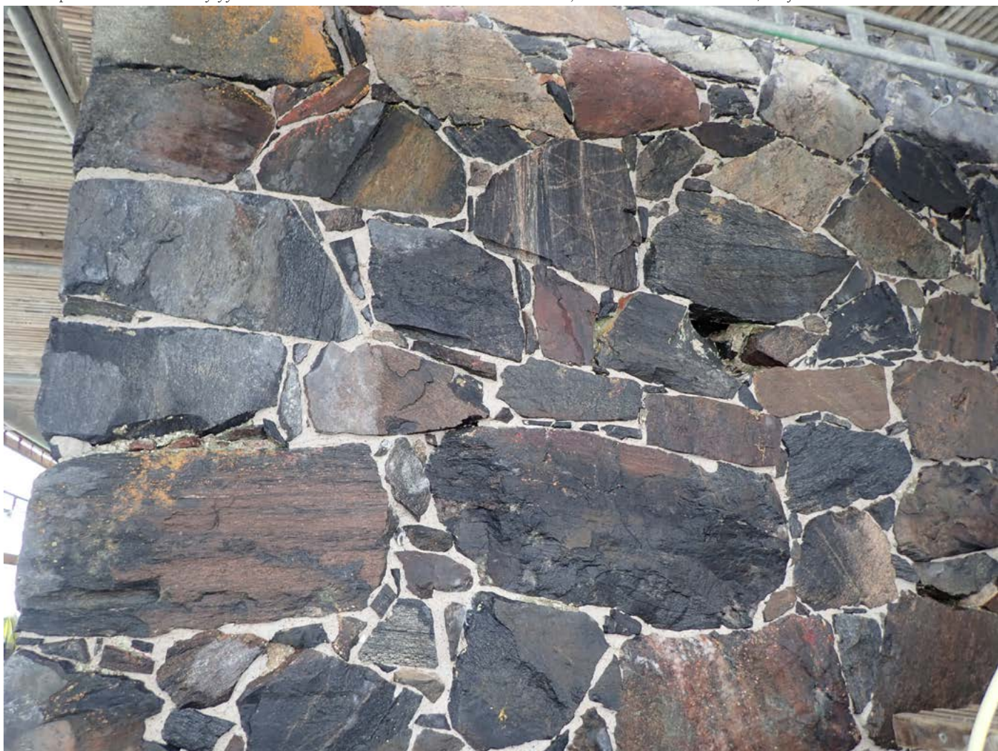
Talviteltassa käsityönä tehty muurin syvätäyttö on onnistunut. Kiilakiviä on riittävästi ja täten sateessa kastuvaa ja sään armoilla olevaa laastia on julkisivussa ainoastaan vähän. Muuri jäi hieman likaiseksi, mutta se pestiin toistamiseen kuvan ottamisen jälkeen. Kuva: Suomenlinna D3, Bastioni Stromberg. 21.3.2019 / Tuija Lind
