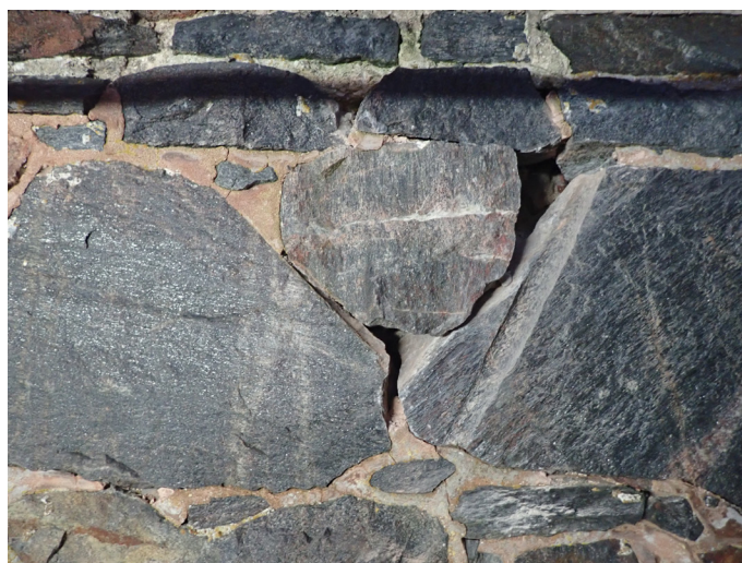
Kuvan muurin (jälki)saumausta laasti on punertavaa ja todennäköisesti peräisin 1800-luvulta. Osa saumoista oli hyväkuntoisia ja ne säilytettiin tarkoituksellisesti. Kuva: Suomenlinna B21, Bastioni Hamilton. 15.12.2020 / Tuija Lind
