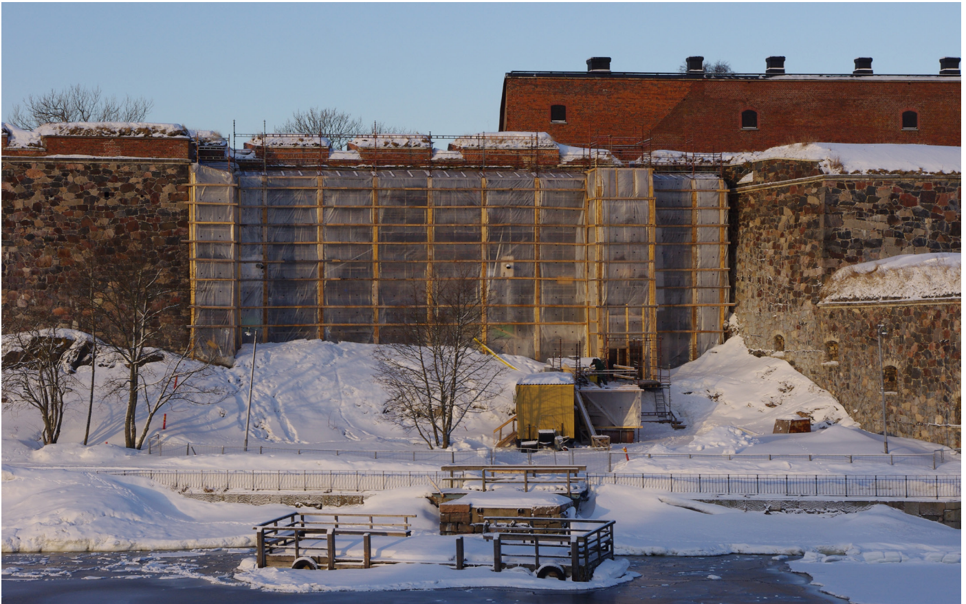
Kuva: Suomenlinna B48, B42, B49. Vankilan lämmitettävä talvityömaatelta. 30.3.2011 / Heikki Lahdenmäki
