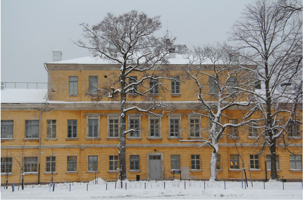
Eteläjulkisivu ja suomalaisella kaudella rakennettu kolmas kerros.
