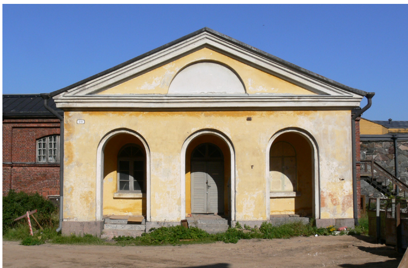
D9:n päätyjulkisivu vuonna 2007.
