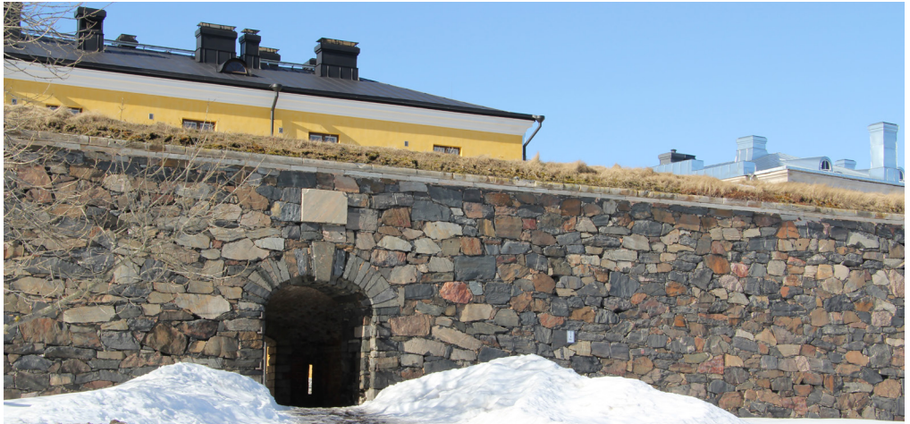
Kurtiinin läpi kulkeva tunneli vuonna 2013.
