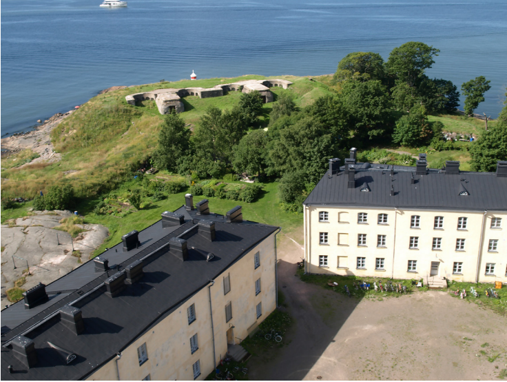
Bunkkeri pohjoisesta nähtynä. Edessä E3 ja E4. Kuva on otettu elokuussa 2011.
