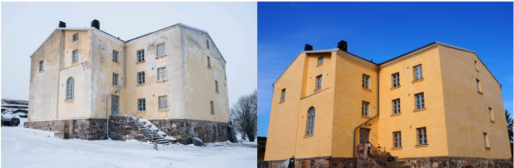
Talvella 2016, ennen rappaustyötä. Elokuussa 2017, rappaustyön jälkeen
