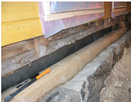
Ulkoseinän alimpia hirssiä vaihdettiin 2004. Oikealla valmis talo.
