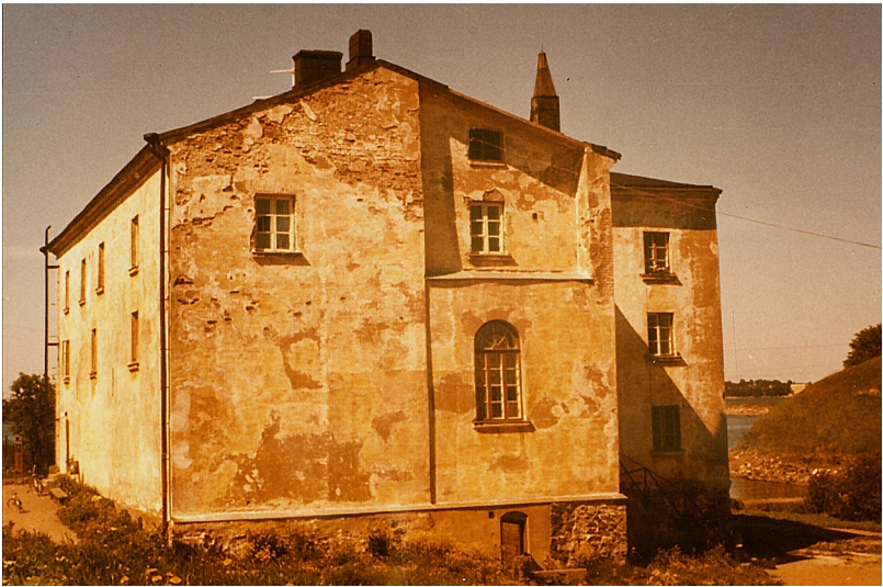
Talon eteläseinä ja ikkunaksi muutettu ovi vuonna 1974.
